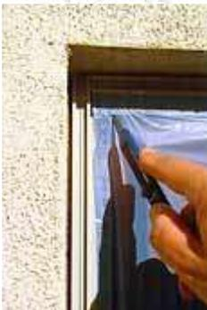
Folie zum Schützen des Fensters, der Türen ... auf die klebenden Flügel/ Laschen aufdrücken. (Schutzmaßnahme für die weiteren Arbeiten)
