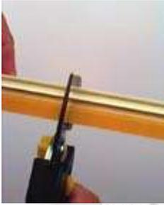
Fenster- oder Türrahmen reinigen und APU-Profil auf die gewünschte Länge abschneiden.
